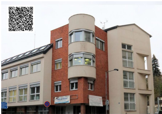
Budova v ulici Zámecká 1845
